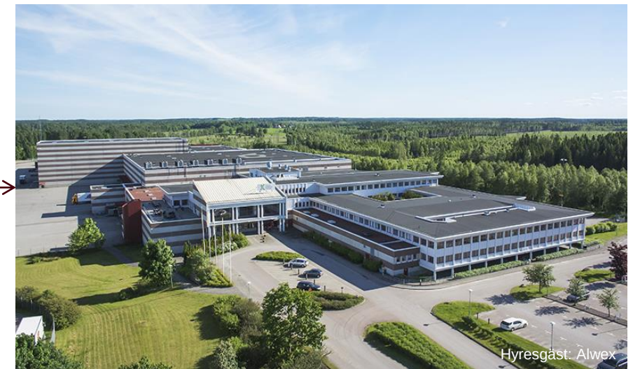
Större, äldre fastighet med låg utvecklingspotential
